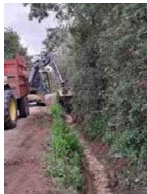
Curage avec le godet trapèze
